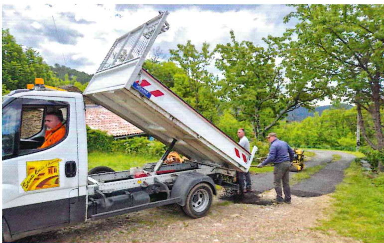
Nos agents techniques polyvalents posent des bandes de roulements, au chemin de la croix des Ponchets.
