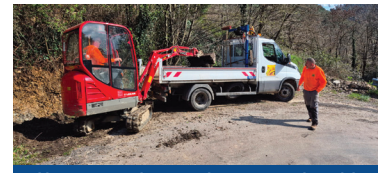
Nos cantonniers sur des travaux de voirie.
