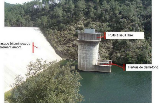
Figure n°3 : principaux organes du barrage
