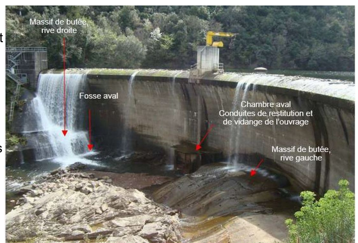
Figure n°8 : principales interventions sur le barrage
