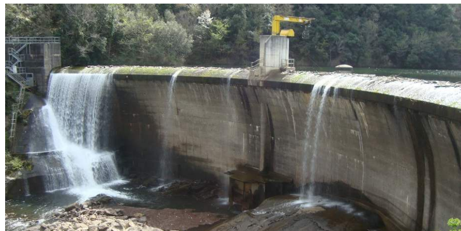
Photographie 3 : Le barrage des Cambous (avril 2019)
