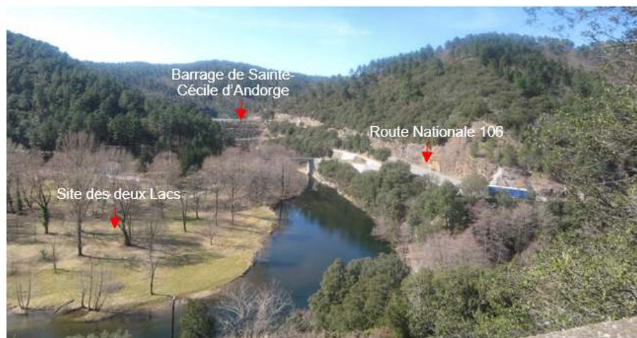
Photographie 5 : Site des Deux Lacs, site retenu pour les installations de chantier du projet soumis à l'enquête
