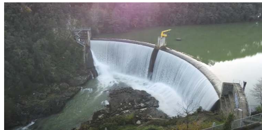
Photographie 4 : Le barrage des Cambous
