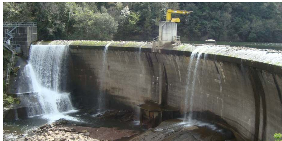
Photographie 3 : Le barrage des Cambous (avril 2019)
